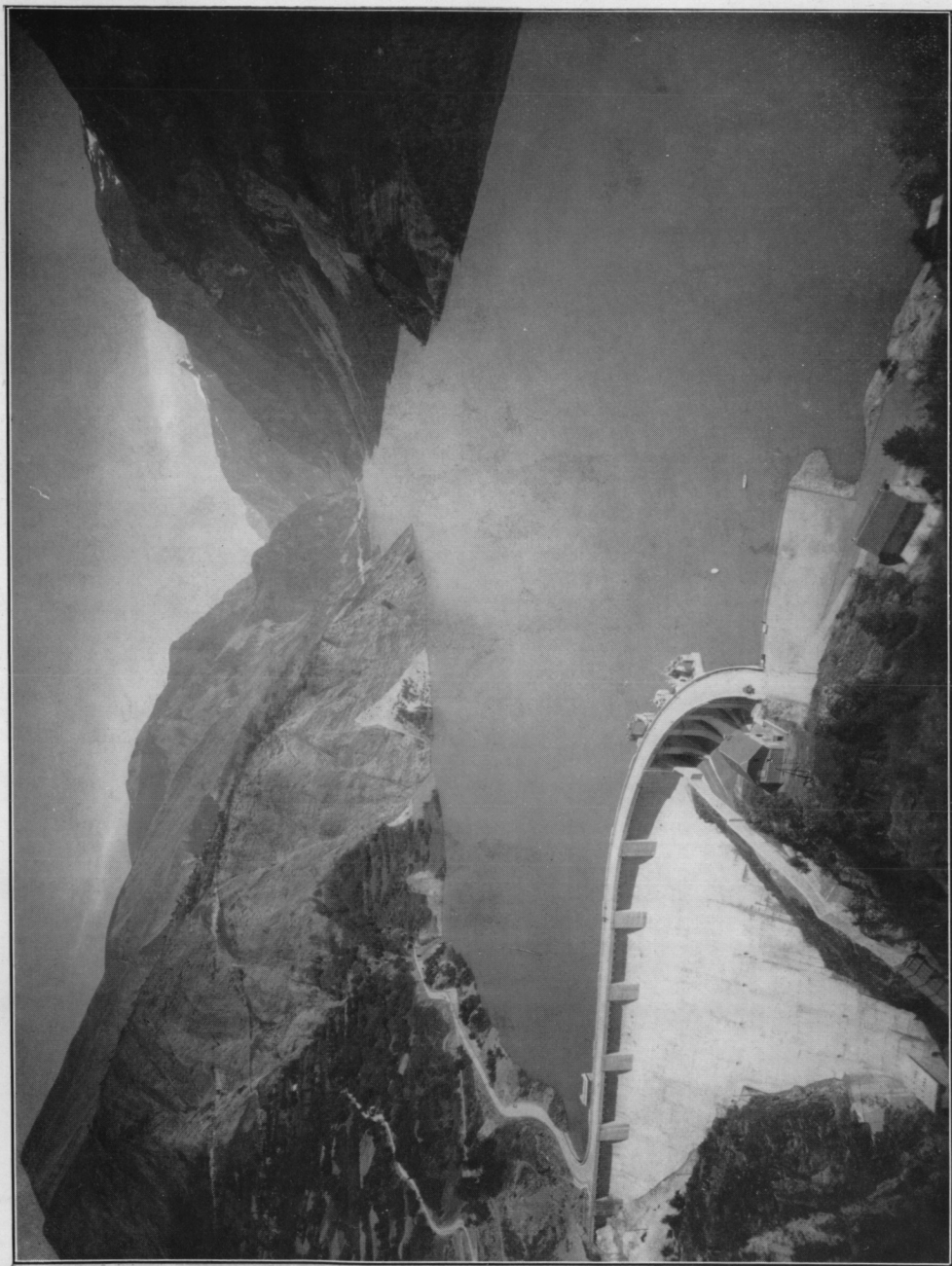
PL. V. — LE LAC DE RETENUE DU CHAMBON. (Vue prise le 4 novembre 1935). Q. O. 14.896. Au milieu, glissement dans les marno-calcaires du Jurassique moyen, provoqué par la mise en eau du barrage. Au-delà, Lias schisteux enveloppant la bosse cristalline, début du Plateau d'En-Paris (extrémité de la retenue). Au fond, enfin, la Meije. (Phot. Oddoux, publiée avec l'autorisation de l'entreprise Campenon-Bernard.)
