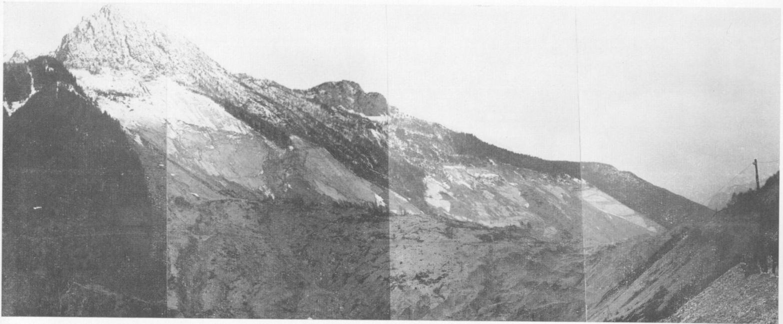
PHOTO n° 3. — Glissement du versant nord du Mont Toc dans la retenue du barrage du Vajont.
