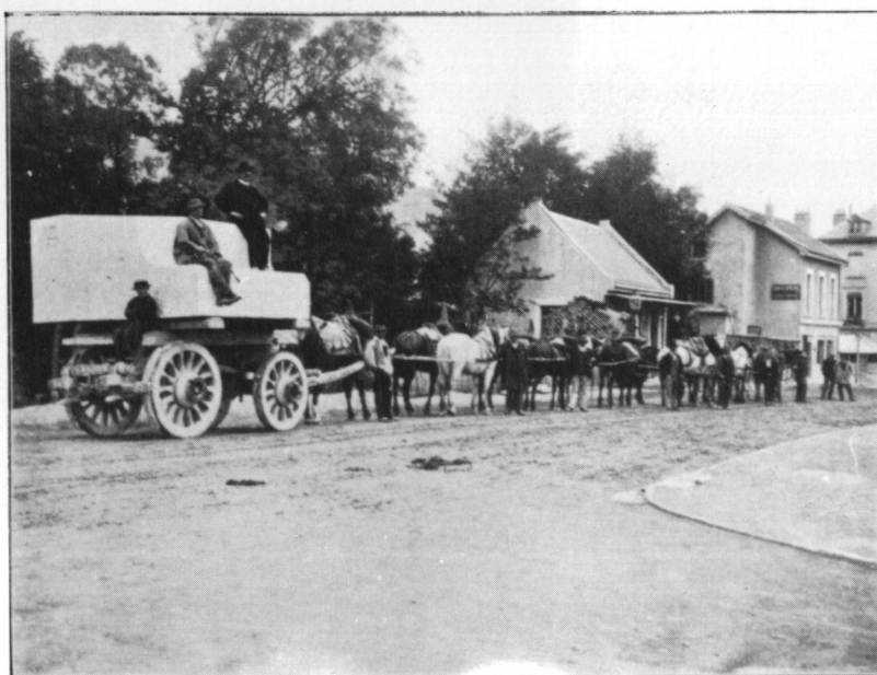
Fig.6. Transport d'un bloc de 20 tonnes en direction de Romans.
